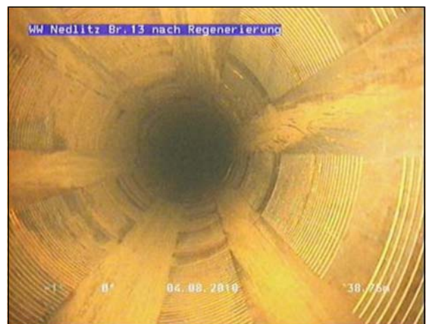
Fotos: Brunnen Wickeldrahtfilter und PVC - Filter geschlitz vor und nach erfolgter Regenerierung durch das hydropuls® -Verfahren.
