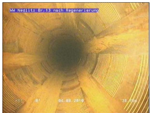
Photos : Filtre bobiné et filtre PVC de puits fendus avant et après la régénération effectuée avec hydropuls®
